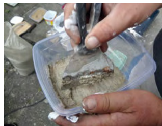
Artífices em demonstração de escolha e manipulação de materiais para o melhor acabamento em cimento penteado.
