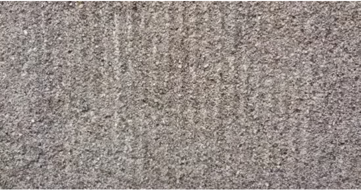
CIMENTO PENTEADO: Argamassa de cimento e areia onde o revestimento recebia acabamento final com raspagem de pente de aço ou lâmina de serra. Apresenta superfície ranhurada.
