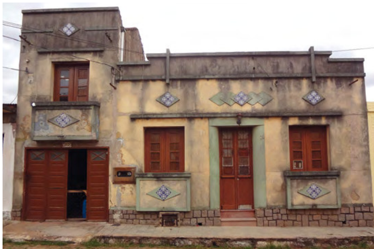
Construção em cimento penteado, em Bagé (RS).
