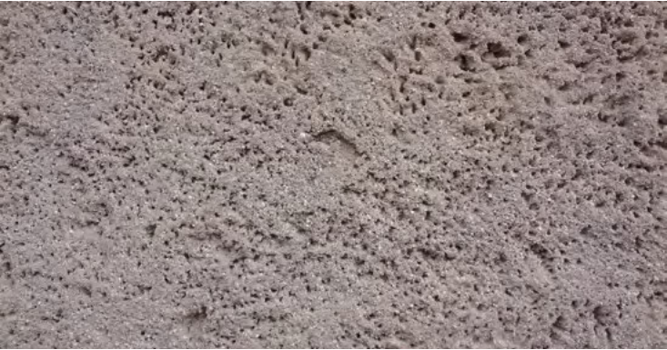
CIMENTO BATIDO: Argamassa de cimento e pó de pedra, com adição de mica onde revestimento recebia acabamento final uma lavagem com ácido muriático. Apresenta superfície lisa.
